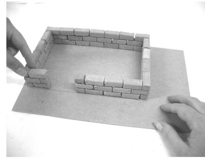
2 - Montez ainsi 3 rangs de briques. Utilisez en alternance les demi briques pour terminer l'encadrement de la porte.
